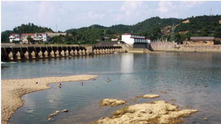
湖南省某以电代柴生态工程项目
