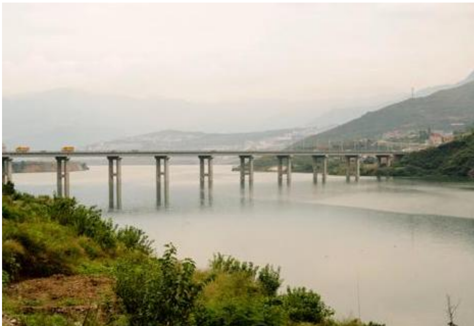
宁夏某流域综合治理项目
