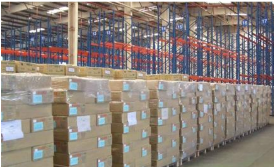
上海某物流仓储建设中心项目
