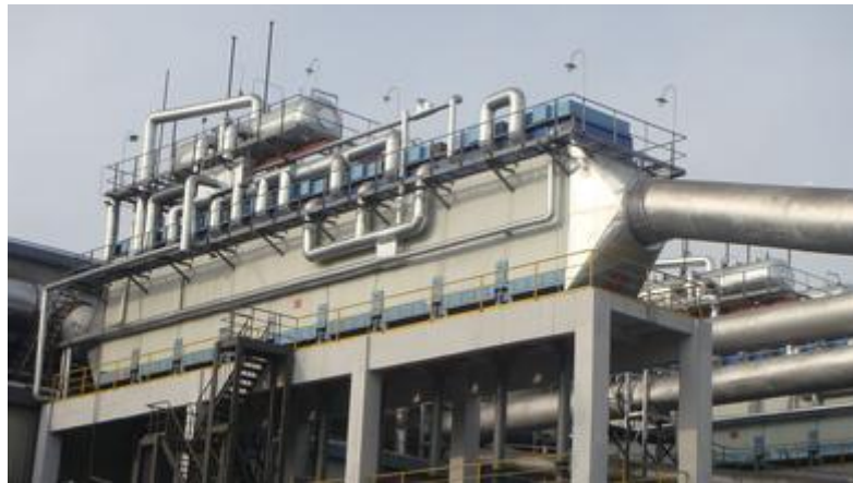
内蒙古铁合金 2×25000KVA 硅铁电炉及配套工程建设项目
