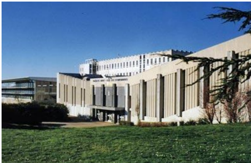
广西省某学院扩建项目
