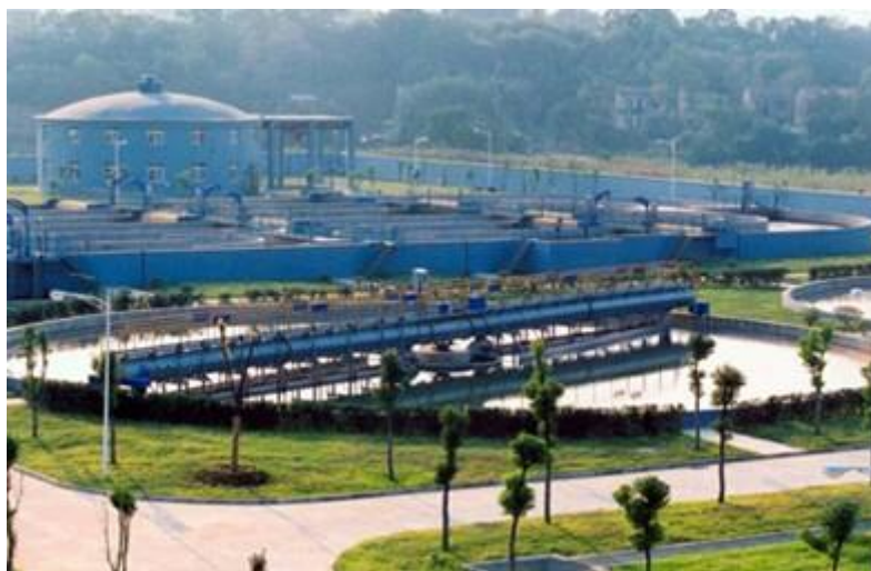
河北省某公司废水处理改造项目
