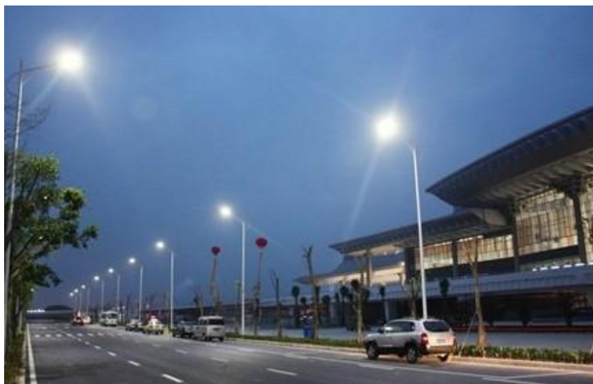
江苏省某公司太阳能 LED 照明灯具
