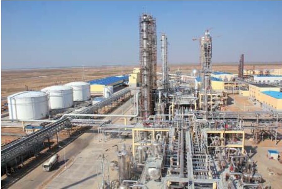
贵州省 60 万吨醇氨工程项目
