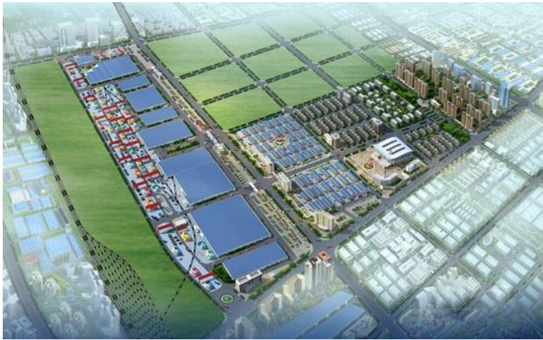
山东省钢铁物流园项目
