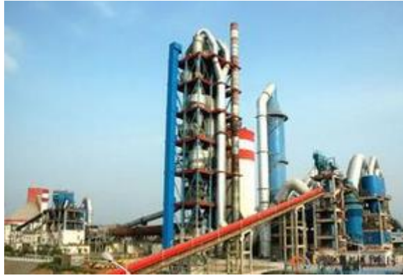
湖北省 60 万吨水泥改扩建工程项目
