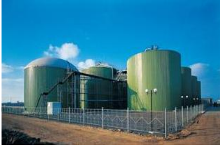
山东省某公司大型沼气工程项目
