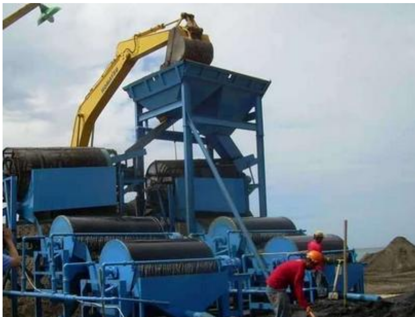
新疆某公司 15 万吨/年铁精粉选厂改扩建项目
