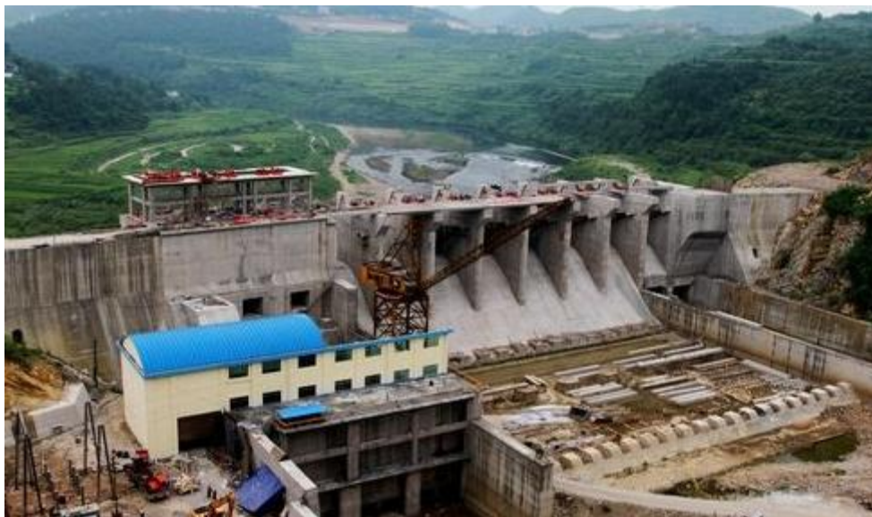
湖北省某水电站建设项目
