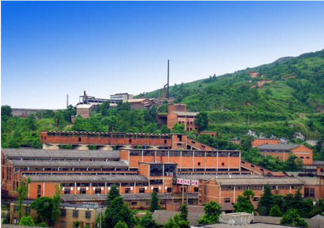
青海省年处理 30 万吨有色金属选厂项目
