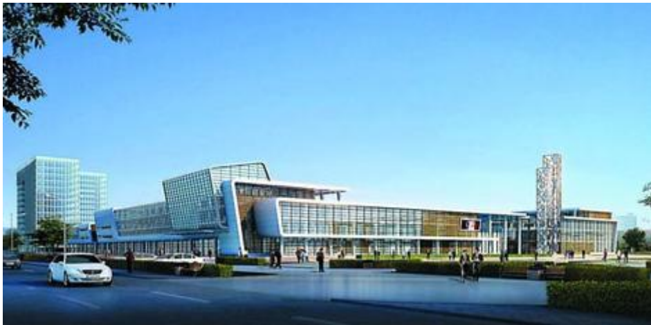
山东省某县汽车车站建设工程项目
