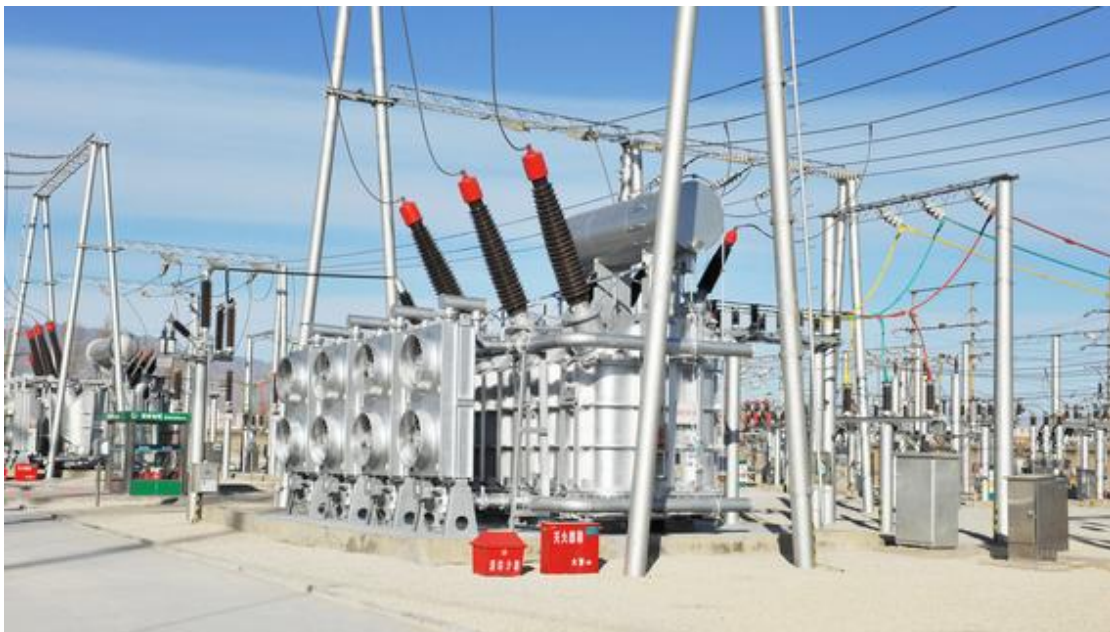
河南省 110kV 输变电工程项目
