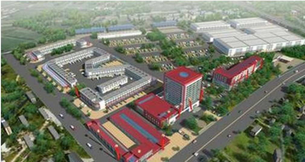
内蒙古某市综合物流园区建设项目
