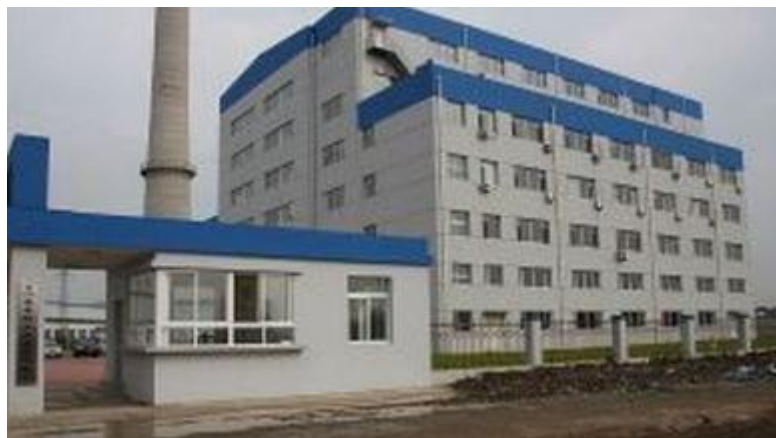
河北省某热电有限公司烟气技术改造项目
