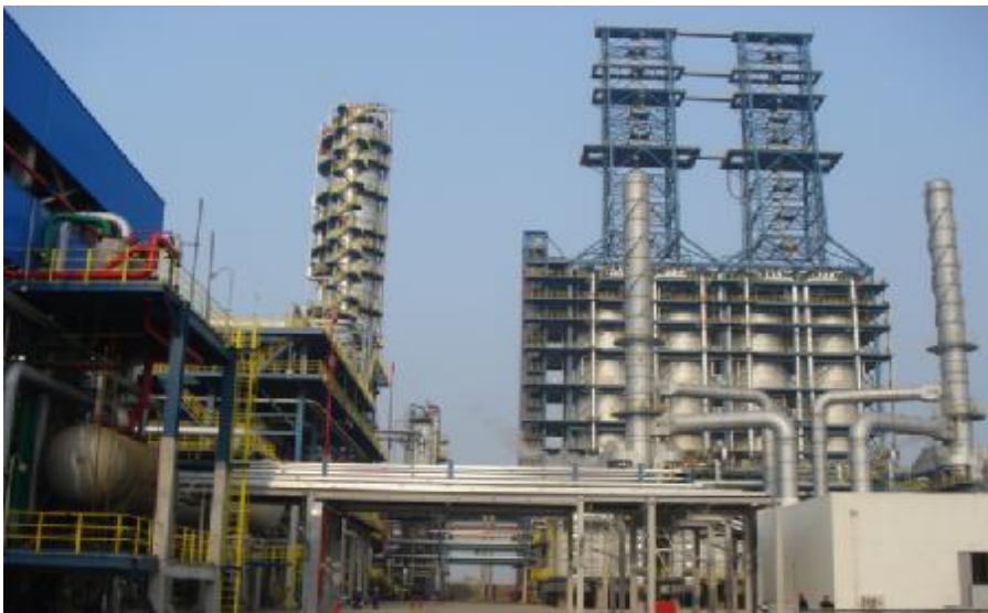
山东省 50 万吨延迟焦化工程项目
