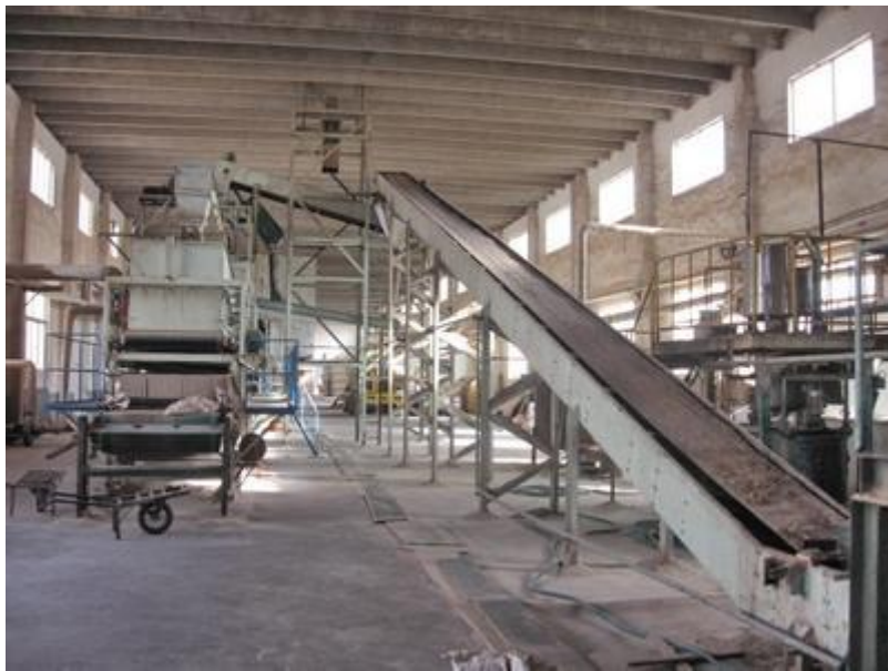
云南省 18 万立方米中密度纤维板生产线建设项目
