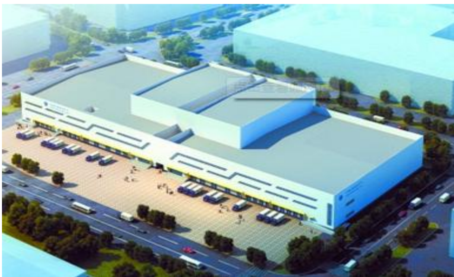
北京通州农产品应急储备冷链物流中心项目
