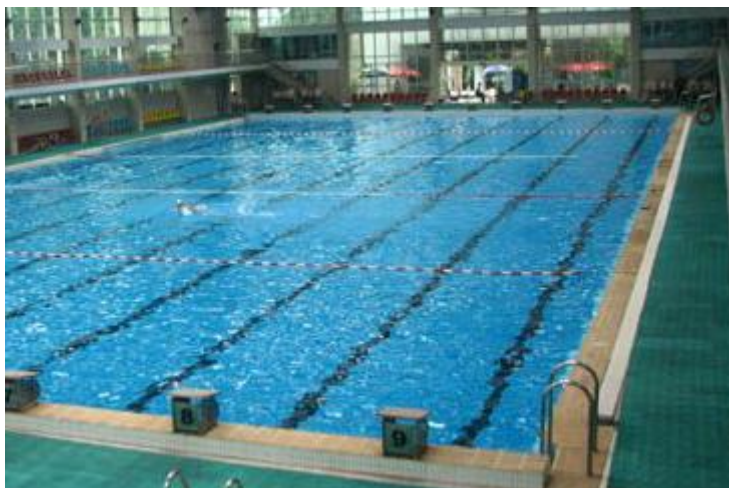
江苏省某大厦游泳馆建设项目
