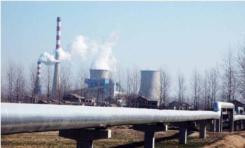
福建省某发电有限公司热网工程项目
