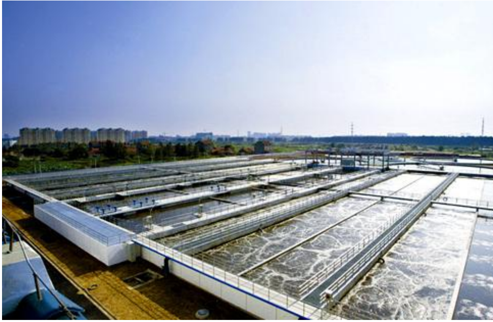
北京市顺义区李桥镇某小区污水处理项目
