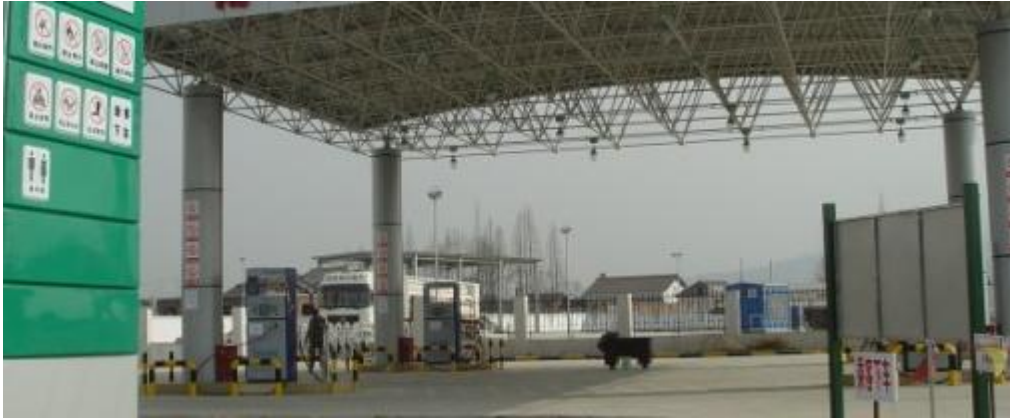
河北省某液化石油气充装站建设项目
