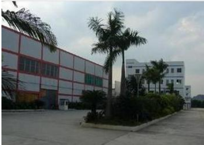
湖南省某医药化工有限公司扩建工程项目
