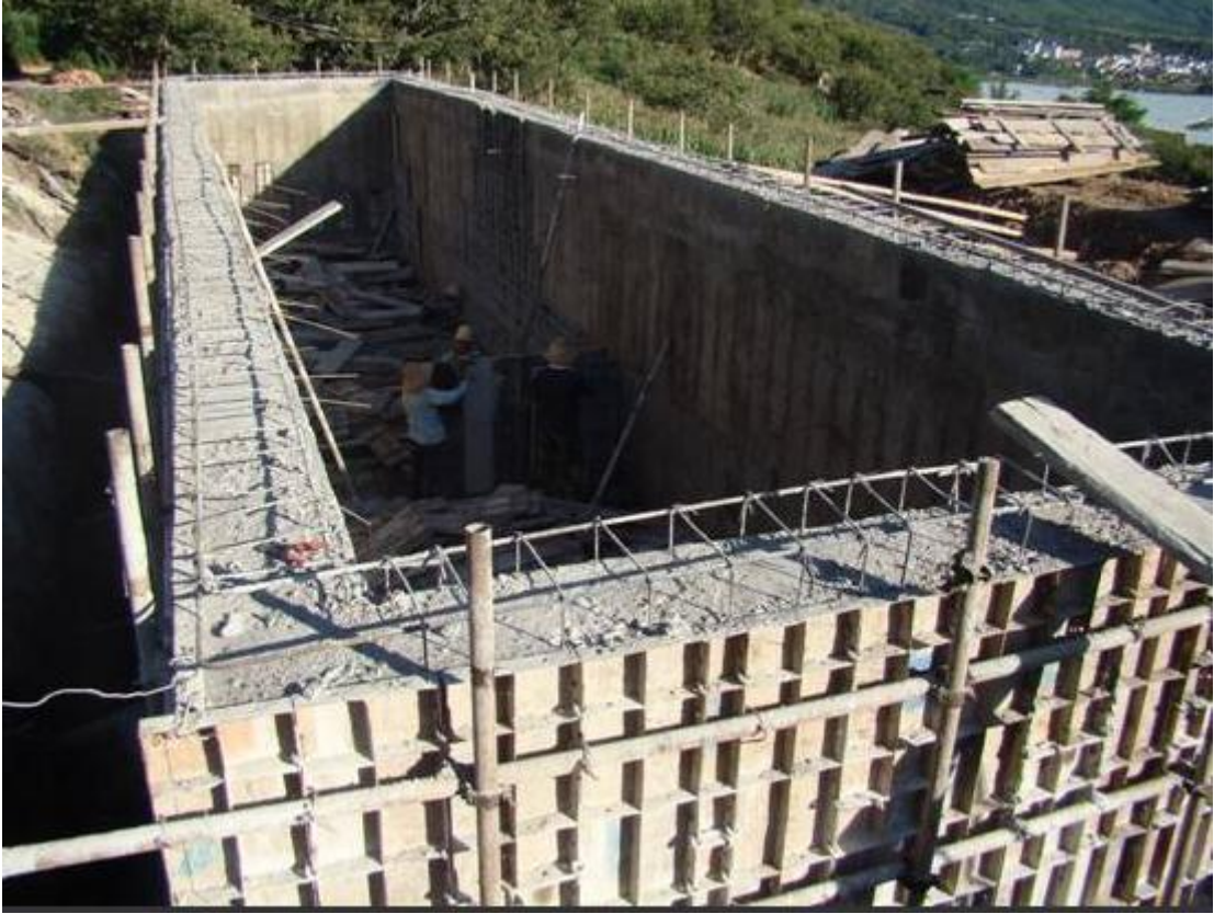
福建省西北某村饮用水工程项目
