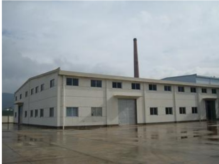
内蒙古某公司纸面石膏板厂建设项目
