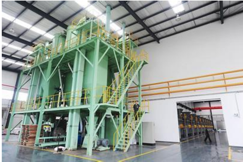
江苏省某市餐厨废弃物收运处理项目一期工程
