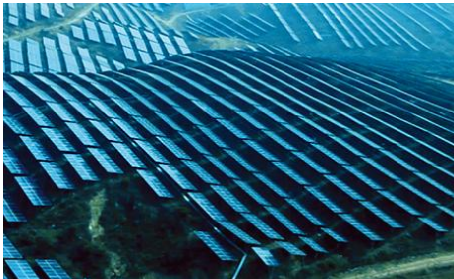
罗马尼亚某公司 45MW 光伏电站项目
