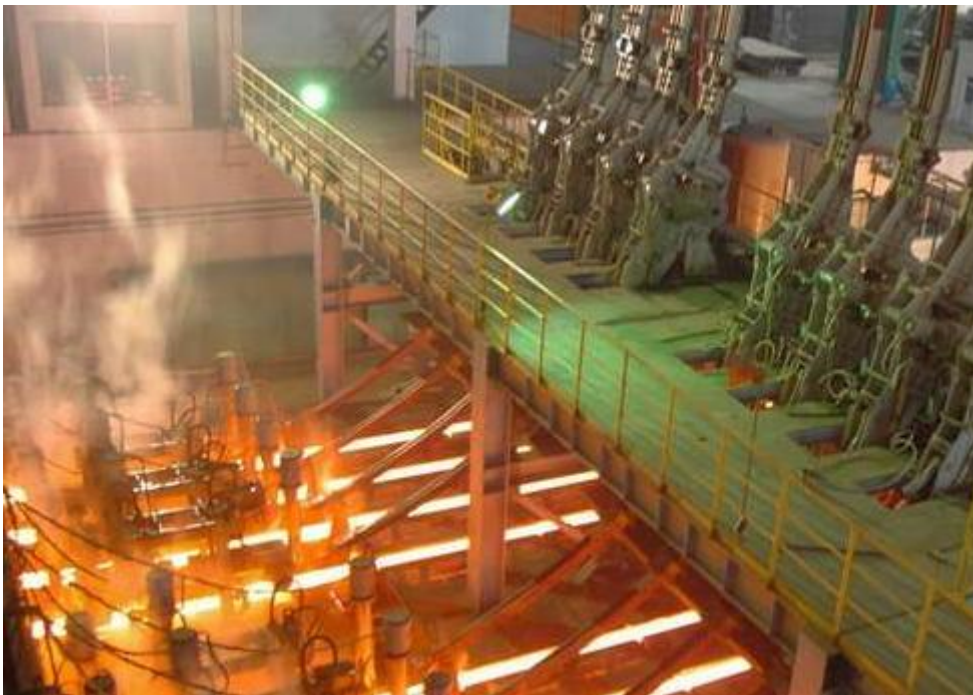
天津某炼钢厂连铸机项目
