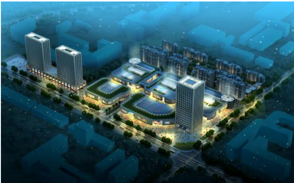
江苏省某电子交易园项目
