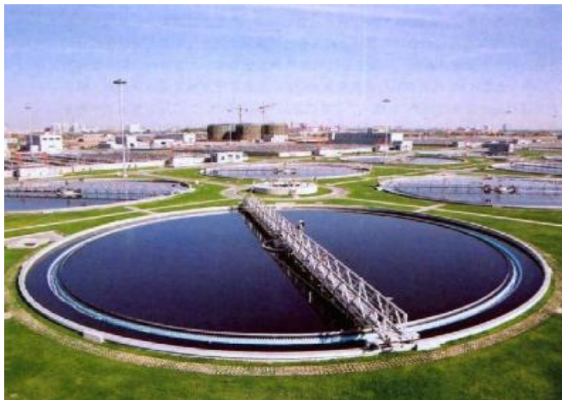
新疆某再生水利用工程项目
