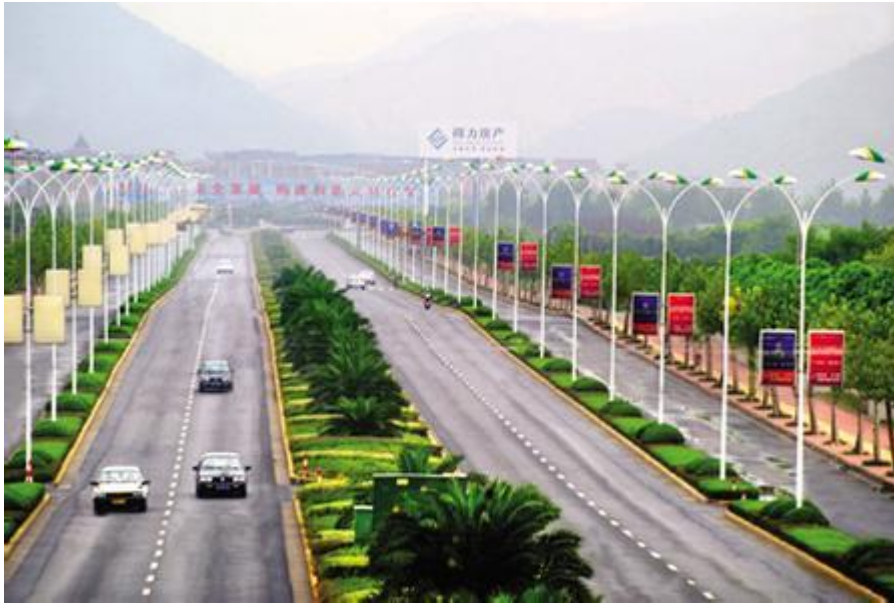
广东省某市政道路项目
