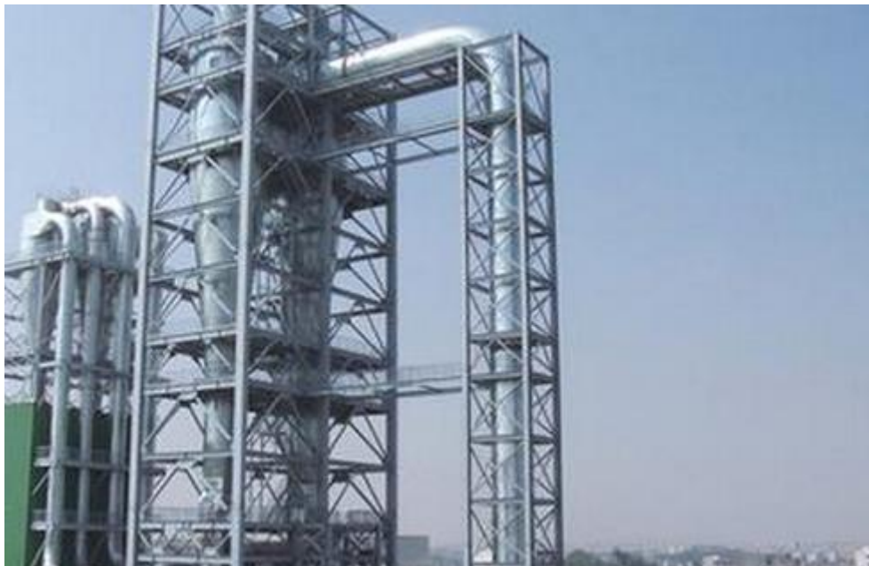
山东省人造板生产系统项目
