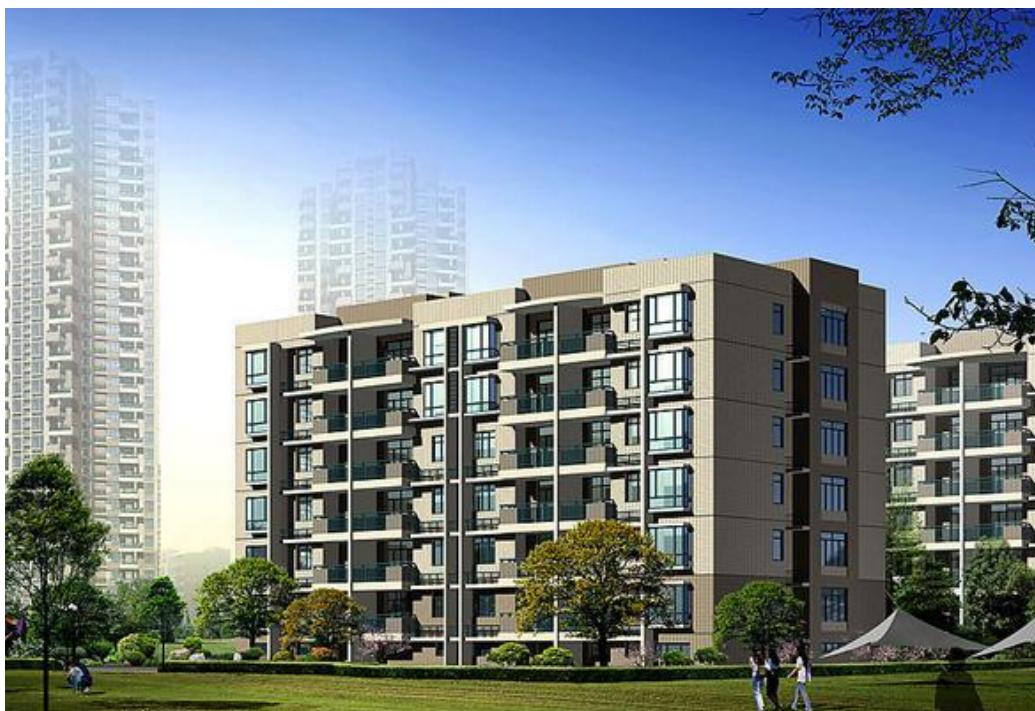
湖南某地产建设项目
