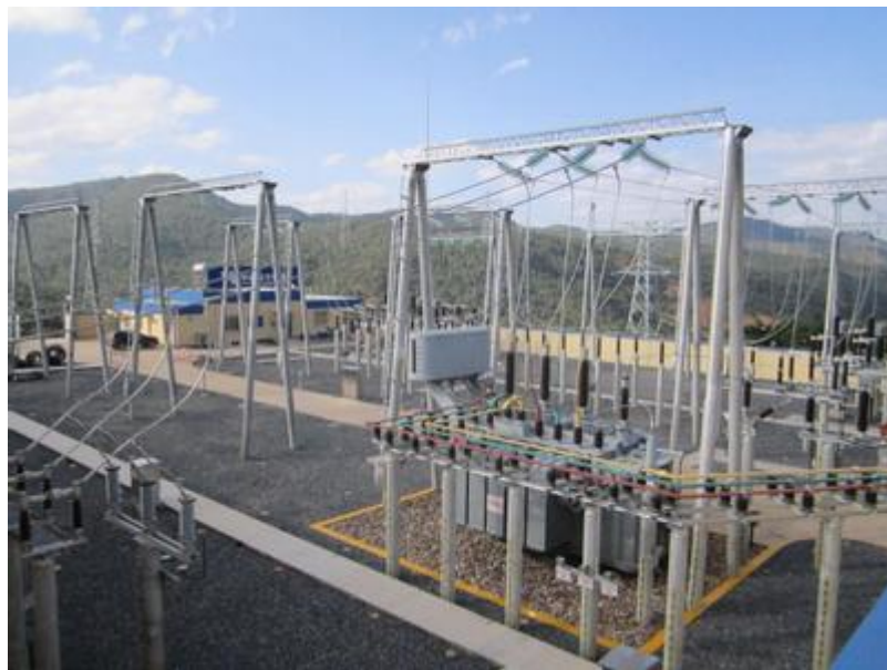
江苏省某输变电新建工程项目
