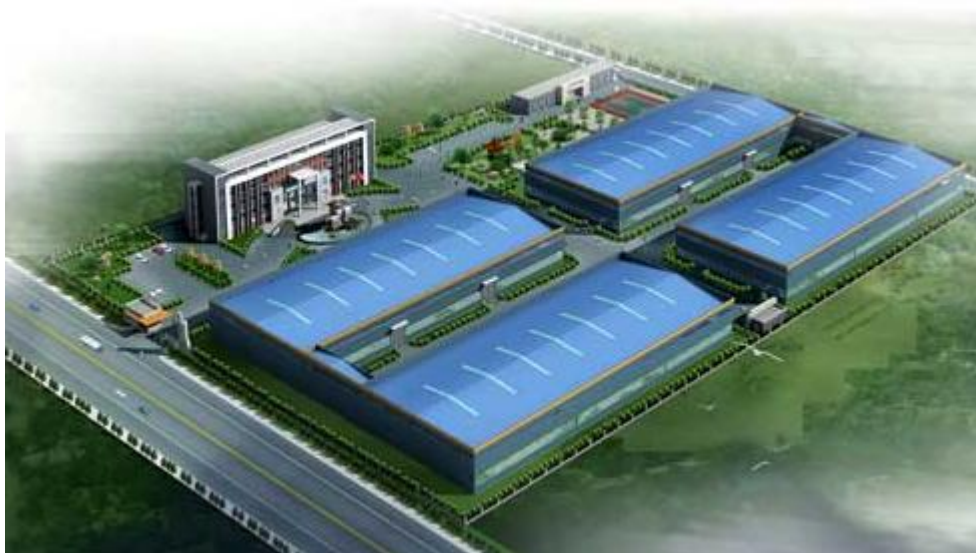
广东省某机械生产基地建设项目
