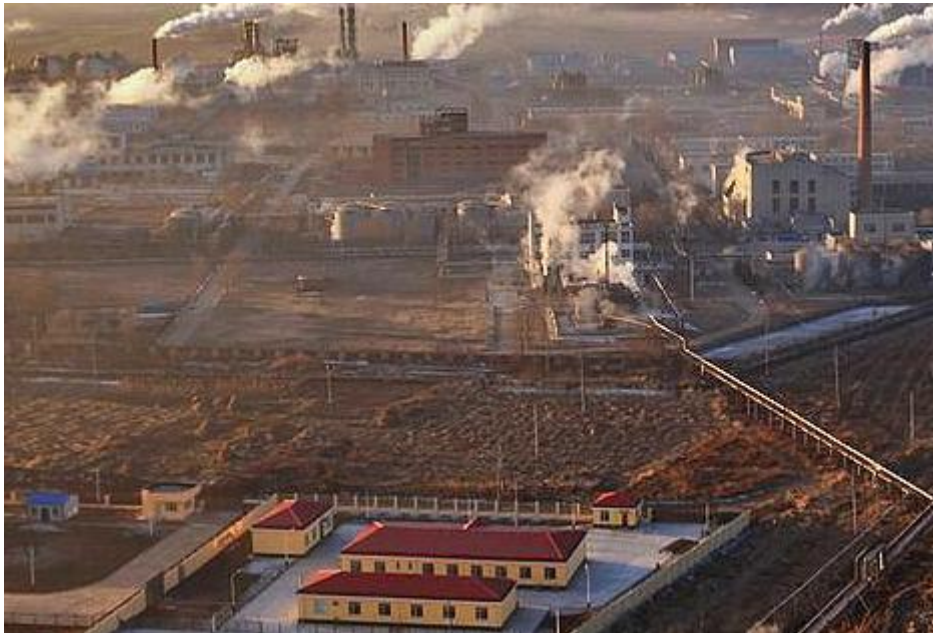
广东省某石化产业园 BT 项目
