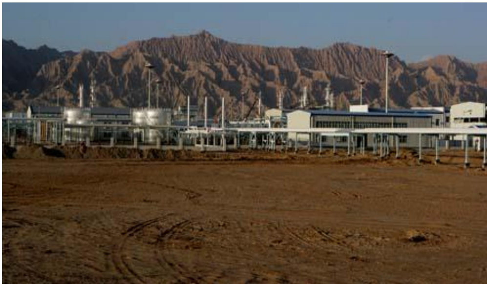
气田地面建设工程项目
