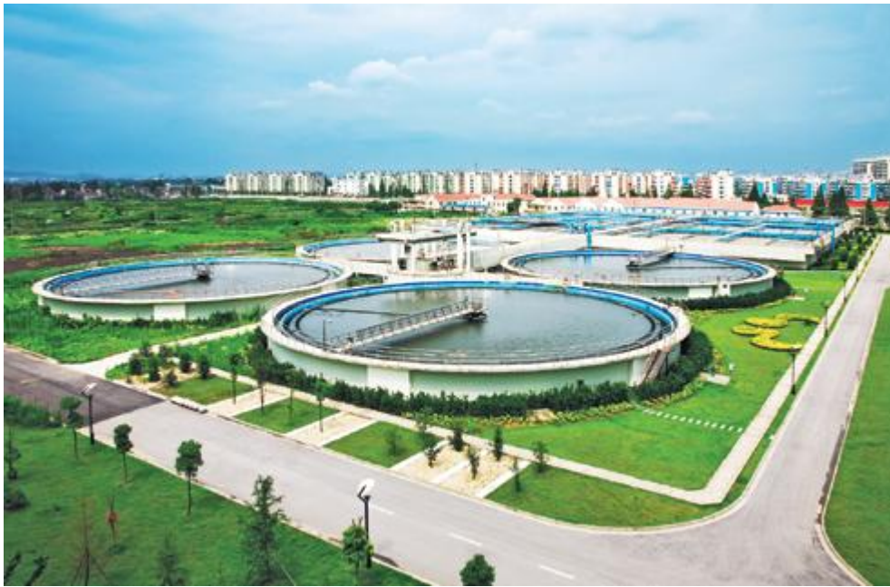
山东省某污水处理厂建设项目
