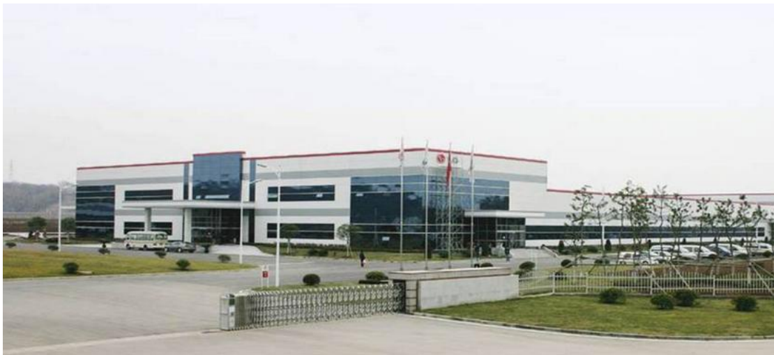
安徽省某公司保温材料项目
