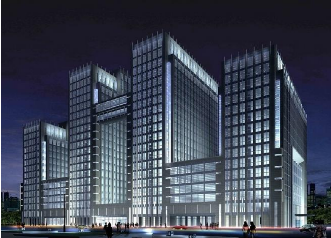
河南省某大厦建设项目
