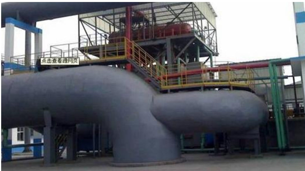
天津某焦化厂引进焦炉烟道废弃余热利用项目
