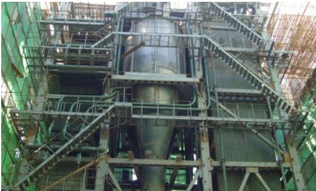
广东 2×300MW 循环流化床锅炉机组建设项目
