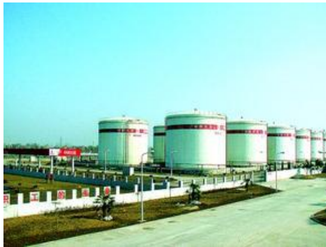
NS 油库二期项目
