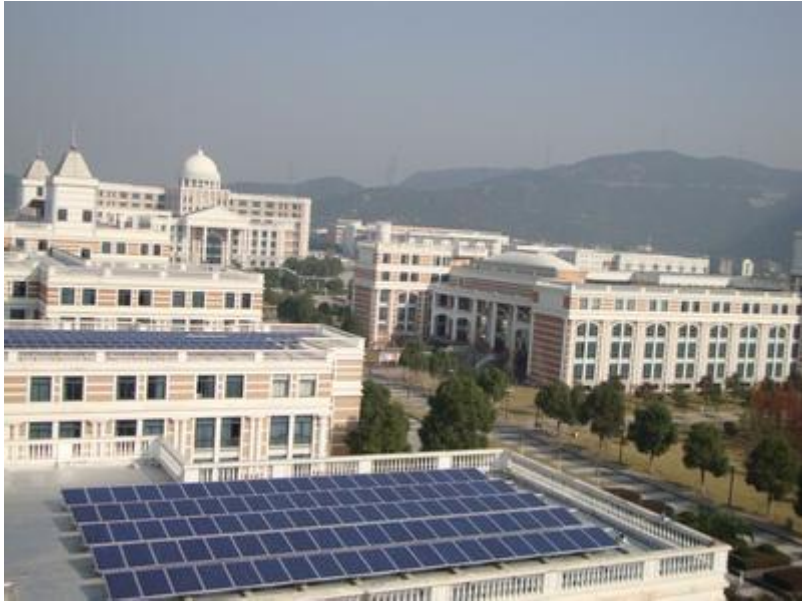
YH 光伏发电并网电站示范项目
