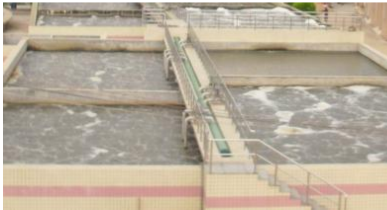
山东省某净水厂供水工程项目
