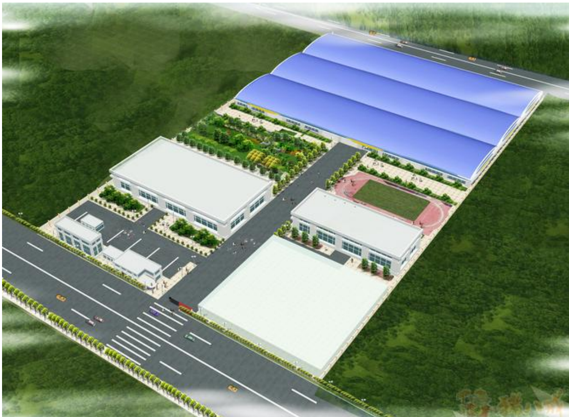
河北省某公司恒温冷库建设项目
