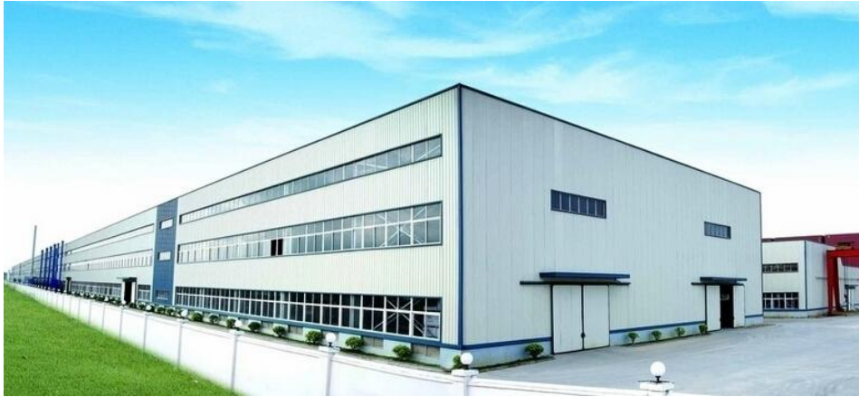
湖南某脱硫脱硝设备生产建设项目
